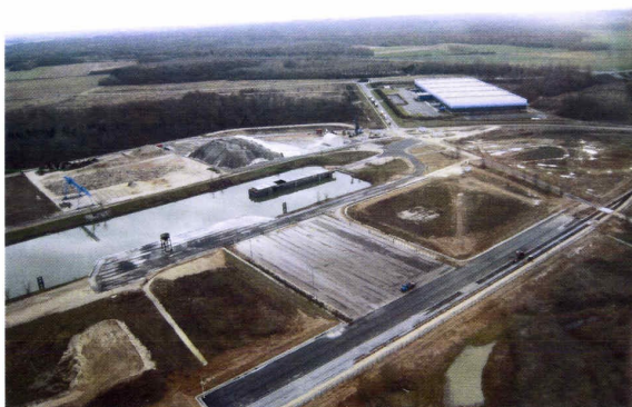
SAS Pagny Terminal
